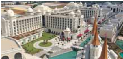
Rixos The Land Of Legends Theme Park Soğutma Kulesi - Soğutma Grupları Isı Pompası - VRF Sistemleri
