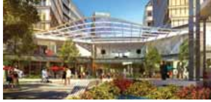
Vadi İstanbul AVM Isı Pompası, Paket Klima, Soğutma Kulesi
