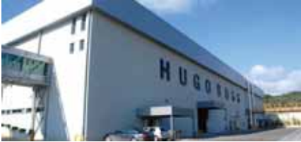
Hugo Boss İzmir Fabrikası Soğutma Grupları
