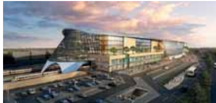
Ankara Hızlı Tren Garı Isı pompası, Soğutma Grubu, Paket Klima, Soğutma Kulesi
