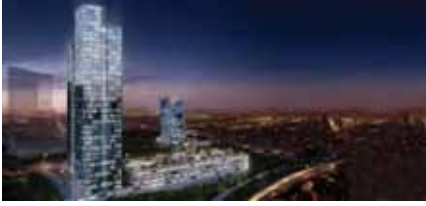
Nidakule Ataşehir Soğutma Grupları
