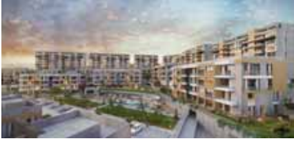
Bahçeşehir Atmaca Konakları VRF Sistemleri
