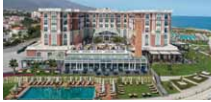
Kaya Palazzo Resort & Casino VRF sistemleri, Soğutma Grupları, Soğutma Kuleleri
